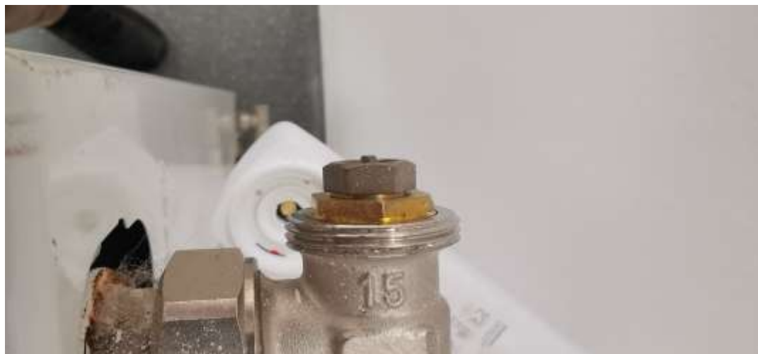
Letapadt szelepek = a beépített radiátorok 20-30% nem is működött.
