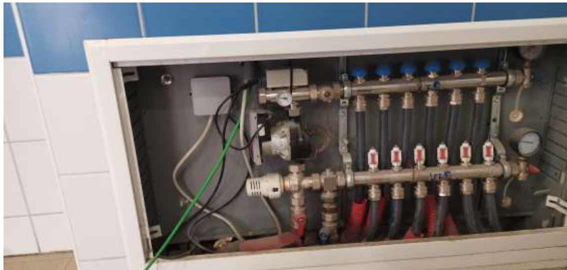
Mechanikus thermofejen és szivattyún a távhő szivattyú áttolja a melegvizet = túlfűtés
