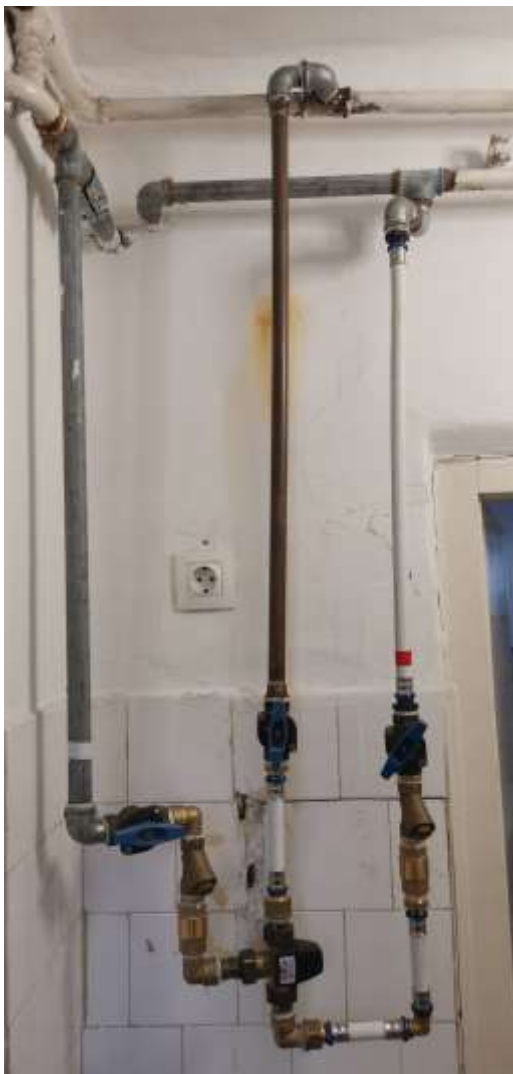
Réz vas kombináció = elektrokorrózió = sorozatos csőtörés
