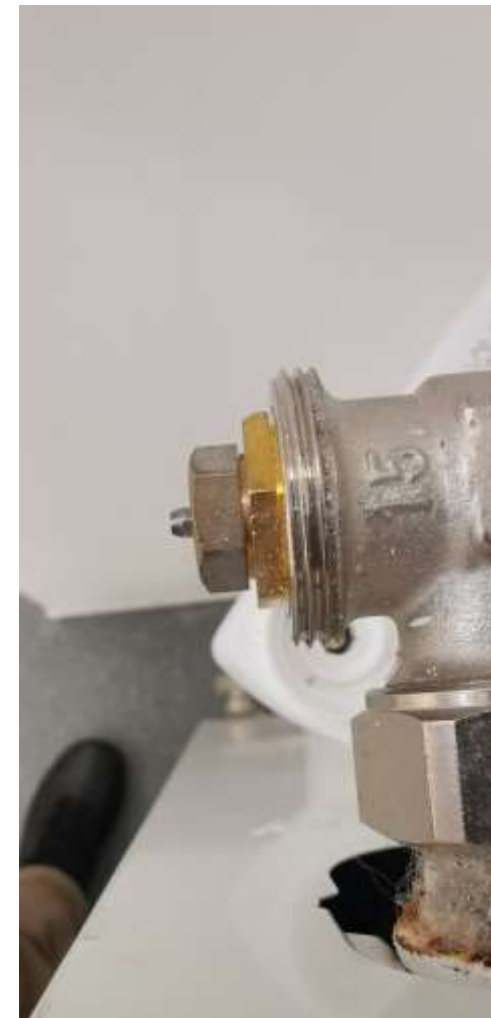
Javított letapadás, így viszont állítani kellett a távhő szivattyú tömegáramát.
